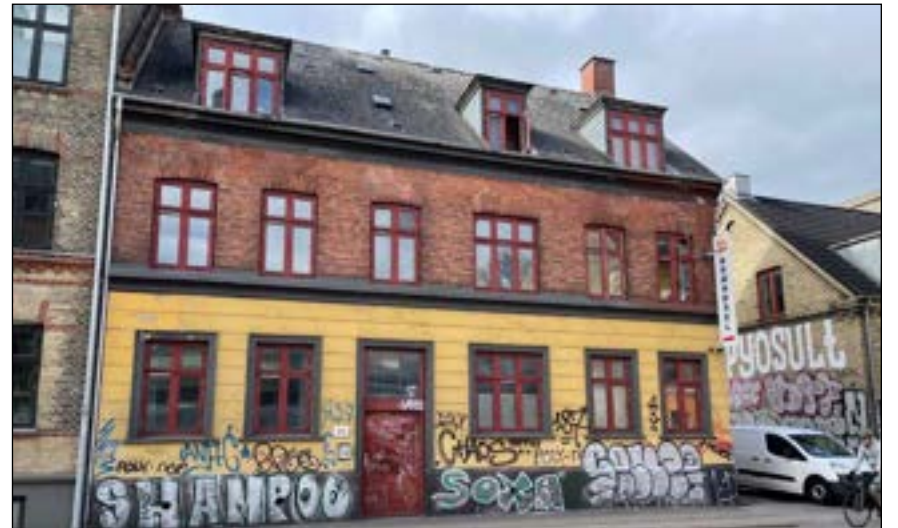
Boligbygningen fra 1892 på Nordre Fasanvej 273 skal nedrives
