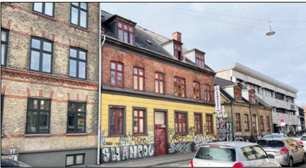
Det er besluttet, at huset i midten, der er fra 1800 tallet, skal nedrives
