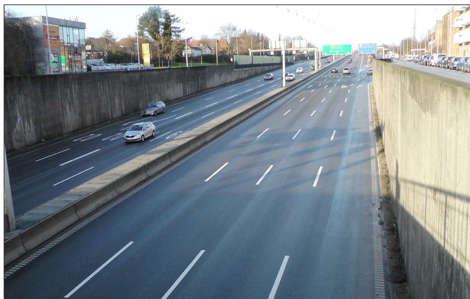
Helsingørsmotorvejen set fra Emdrupvejbroen med kig mod nord. Billedet til venstre er samme kig efter etablering af en overdækning.
