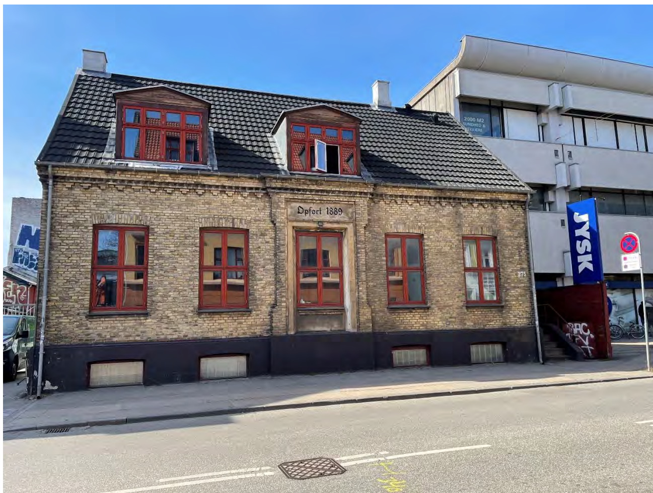
Asylet på Nordre Fasanvej, hvor opførelsesåret ses på det tidligere indgangsparti.
