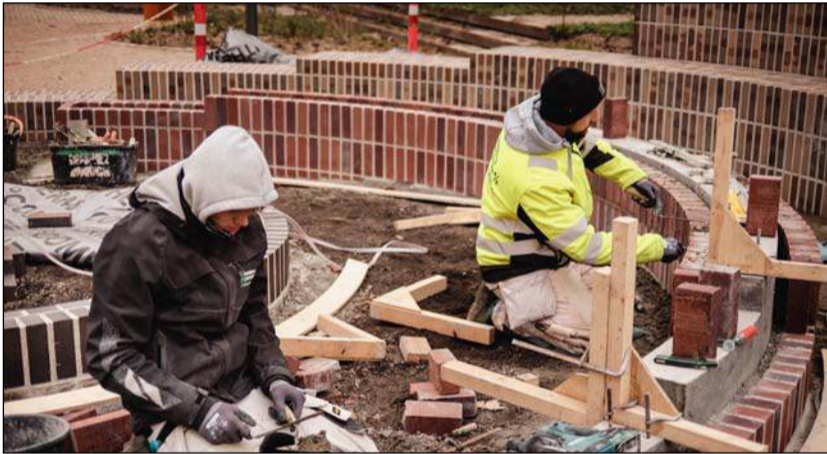
På billedet ses murernes konstruktion af NV Cirklen
