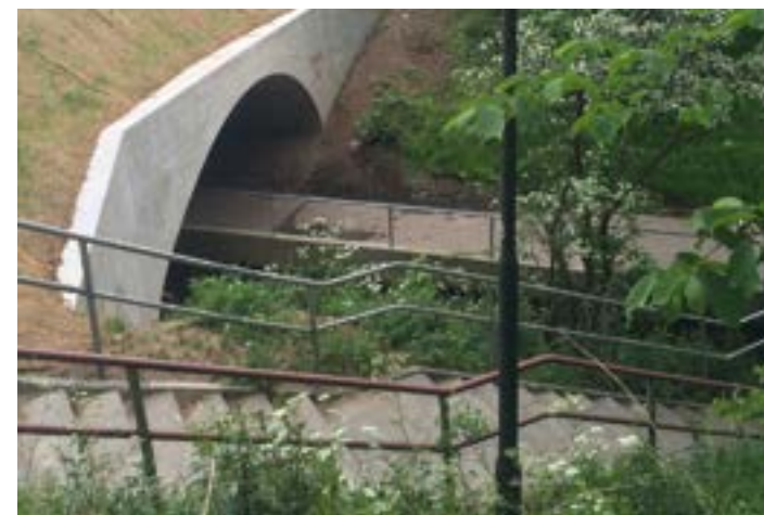
Passage under Frederiksborgvej med trappe til vestside.
