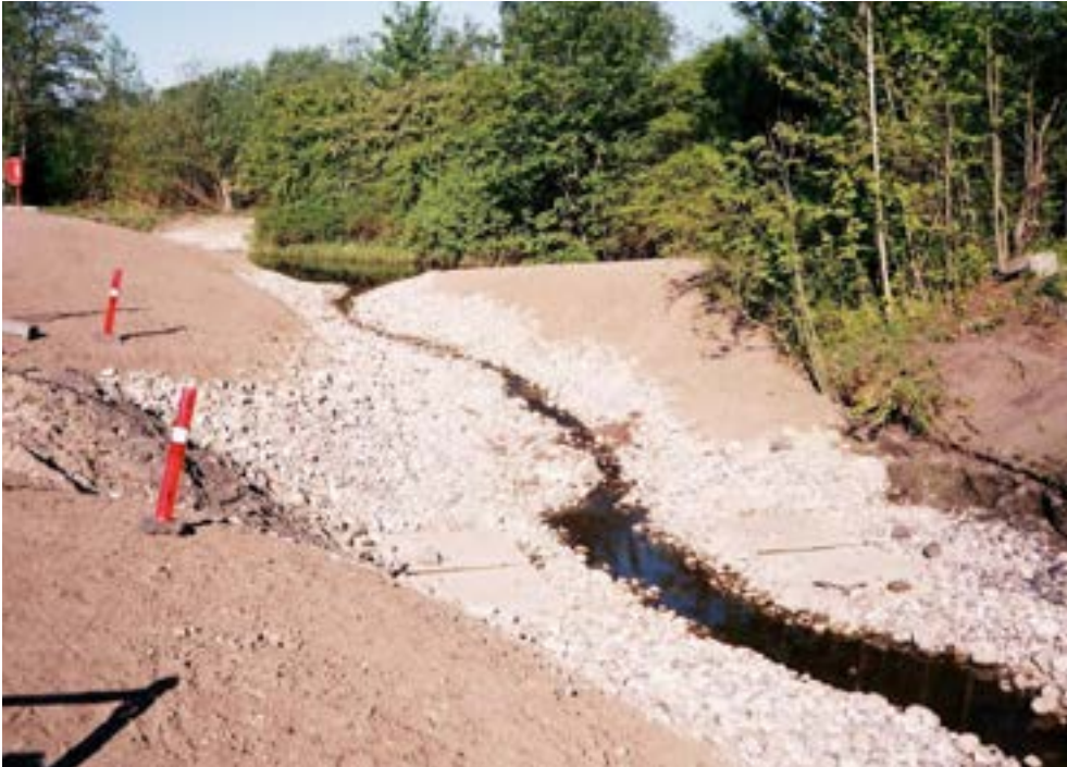
Søborghusende zone 1 under restaurering set mod Nordkanalen
