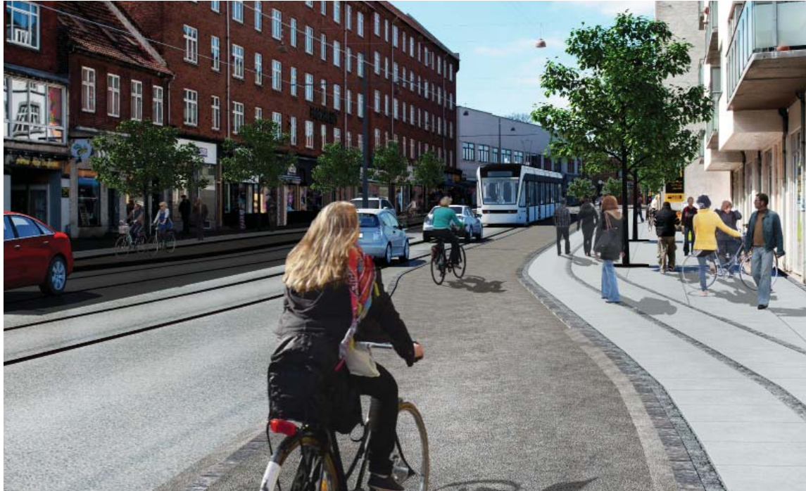
Eksempel på udformning af smal strækning hvor biler og letbane deler kørespor (øst for Brønshøj Torv) .
